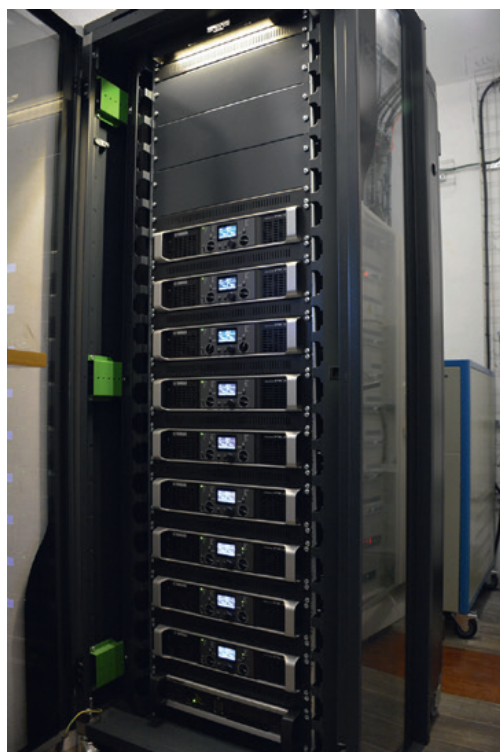
Cette baie regroupe les dix amplis Yamaha pour un total de 12 Kwatts. © O. Verrecchia
