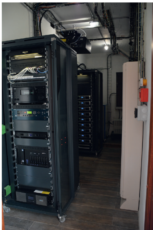
Le local technique de 10 m 2 n'est pas de trop pour regrouper les transformateurs, les armoires électriques, lumière et vidéo, le coffret DMX, le rack audio-vidéo et le rack amplificateurs. Le projecteur accroché au plafond est le seul à ne pas prendre de place au sol. © O. Verrecchia
