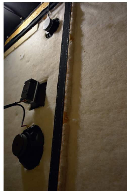
Monté en panneaux plan, les haut-parleurs sont parfaitement disposés derrière l'écran transparent acoustiquement. © P.Regger
