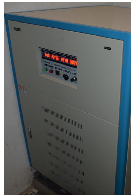
Le convertisseur de tension et le transfo d'isolation électrique sont remisés au fond du local. © O. Verrecchia
