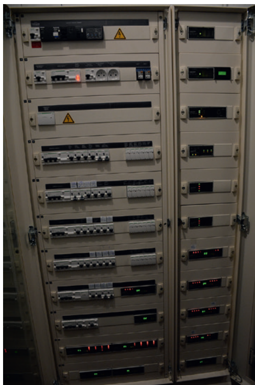
Cette armoire électrique pour les services non audio-vidéo regroupe gradateurs, circuits lumières et protections pour la climatisation. © O. Verrecchia
