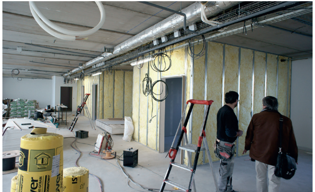
Exemple de mise en œuvre d'une cloison acoustique à double paroi. « Le plus simple, explique Florian Louineau, est d'utiliser des plaques de plâtre techniques, optimisées pour l'isolation acoustique comme la Placo DuoTech 25 par exemple... » © F. Louineau
