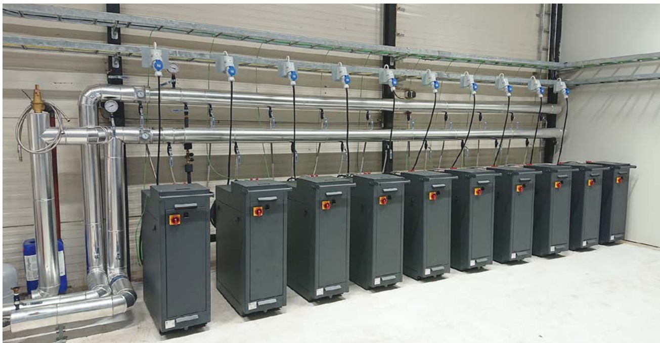
Dix chaudières QB1 de Qarnot Computing, renfermant au total 240 processeurs (jusqu'à 3 000 cœurs de calcul).
