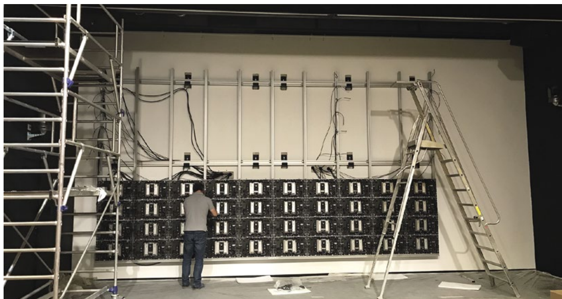
Écran Led 4K de 20,86 m 2 en 1,5 mm dans l'amphithéâtre du siège d'Amadeus.
