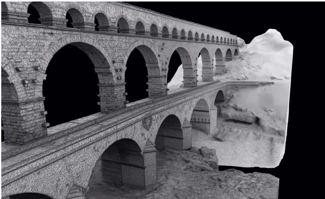
Le jumeau numérique du Pont du Gard (ici, un rendu filaire du modèle 3D) permet au gestionnaire du site d'effectuer un véritable diagnostic à distance du monument. Il a servi par ailleurs de décor virtuel dans un téléfilm. © Art Graphique et Patrimoine
