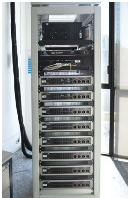
De haut en bas : PC - processeur Xilica - switch Ethernet - huit amplis Yamaha de quatre canaux chacun. Un signal Dante multicanal est envoyé sur IP du PC au processeur puis aux amplis puis aux enceintes.
