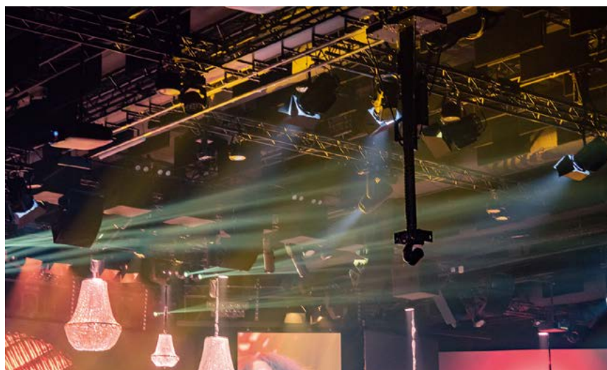
Une caméra PTZ UE150 de Panasonic se promène sur son rail de travelling Technopoint de 20 m de long installé à 7 m de hauteur et parcourant presque toute la longueur de la salle. © Luc Bara
