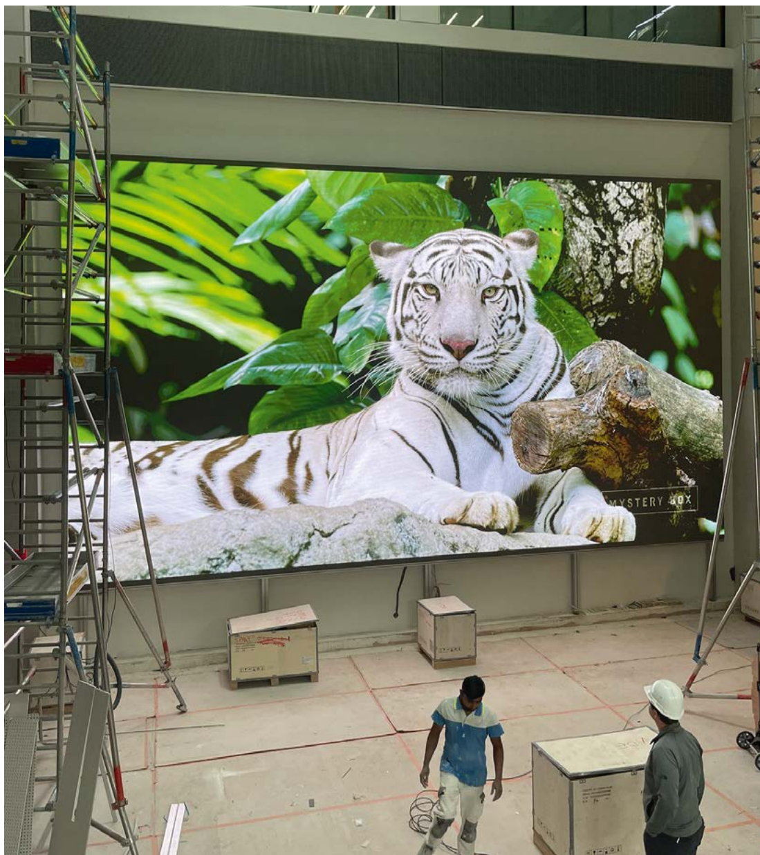
Autre installation majeure pour le compte d'Equans missionné par le groupe Sanofi, avenue de la Grande Armée, avec un écran de 52 m 2 en 2,6 mm de pitch.
