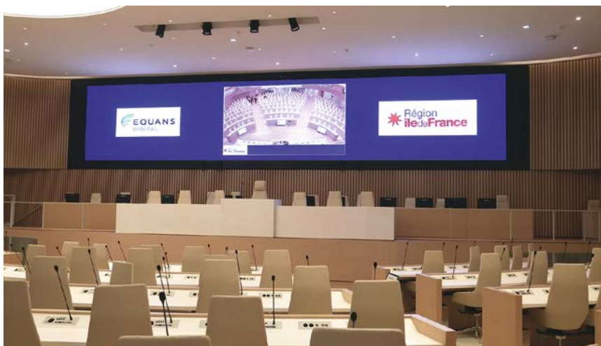
Dans l'hémicycle, la diffusion des images est assurée par un mur à Led de 10 m x 4 m associé à un dispositif d'affichage multifenêtres d'Extron. © PA Taufour
