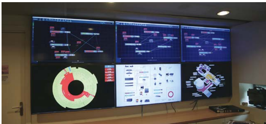
Dans la salle de supervision audiovisuelle, les trois écrans supérieurs affichent l'état des équipements actifs des trois salles 150, 200 et 300 places grâce au logiciel Araneo de Luminex. © PA Taufour
