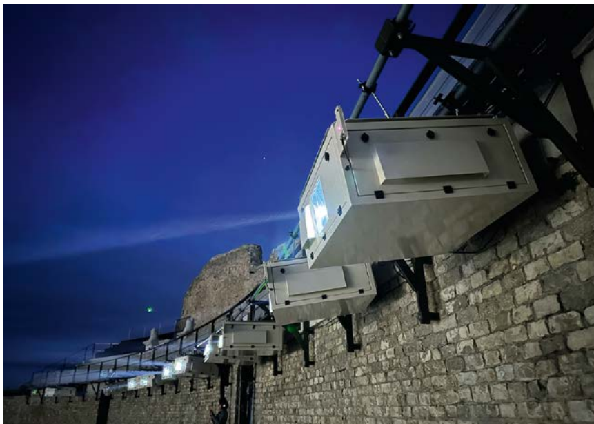
25 vidéoprojecteurs 22 000 lumens Barco G100 ont été enchassés dans des caissons qui respectent le cahier des charges de la Direction des Monuments Nationaux. © Nathalie Klimberg
