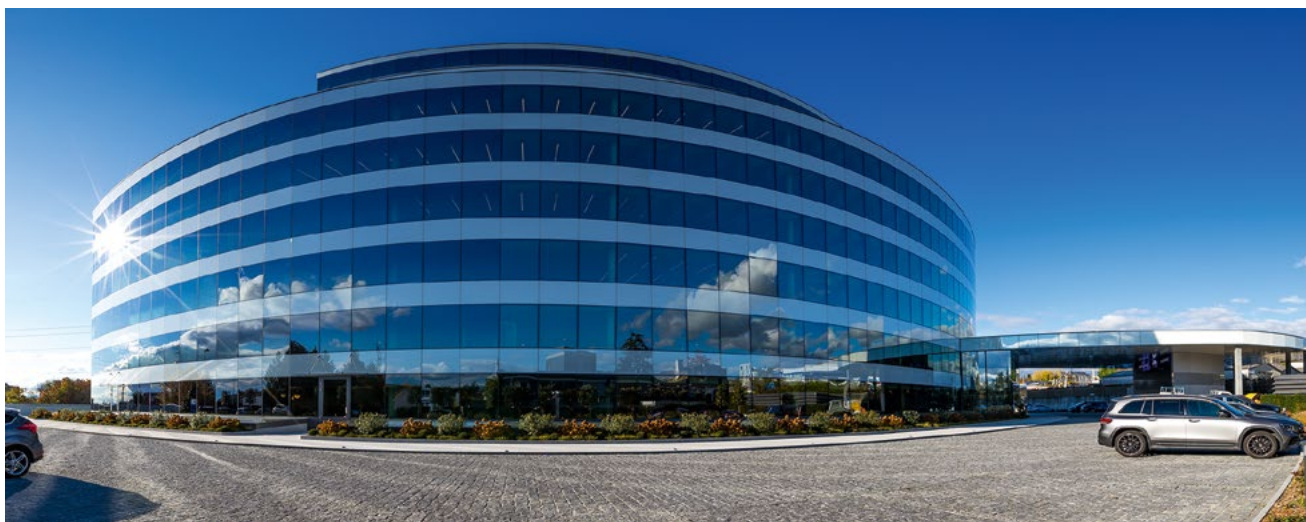
La teinte des vitrages du Millennium est pilotable. © Millennium
