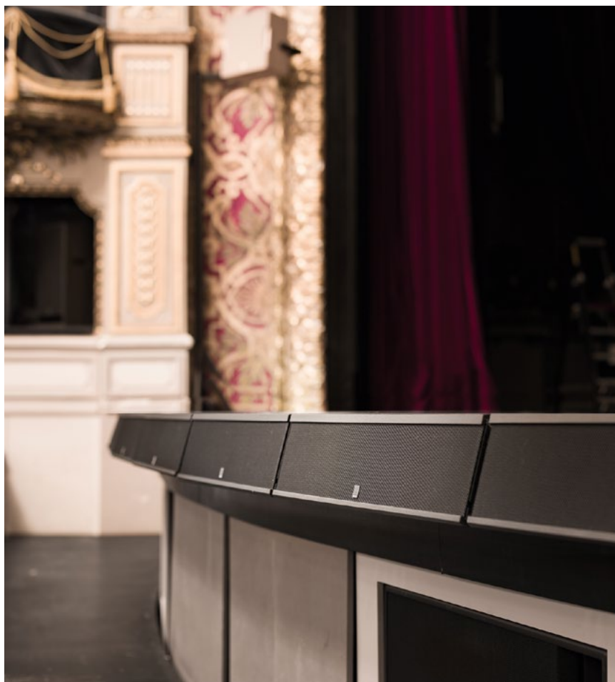
Une rampe sonore front-fill, pilotée selon les lois de la Wave Field Synthesis via le processeur Holophonix complète l'installation stéréophonique. © Amadeus / Holophonix
