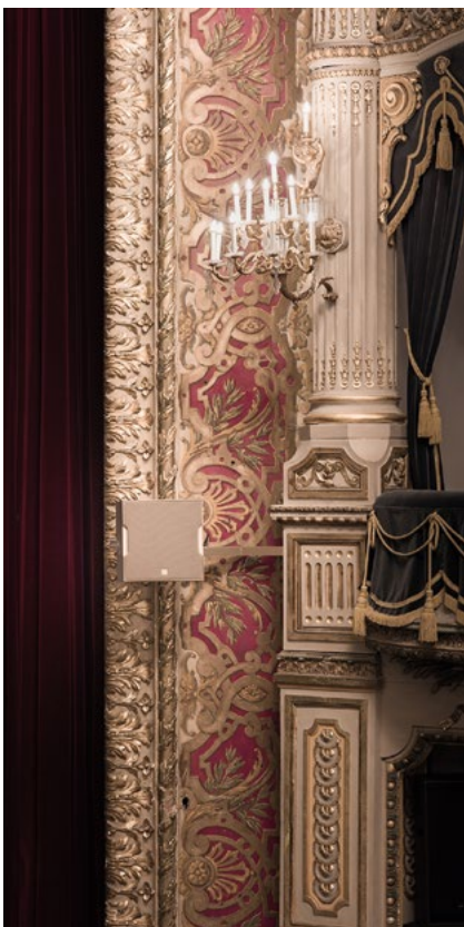
Un système de sonorisation intégré avec discrétion dans l'architecture du théâtre. © Amadeus / Holophonix
