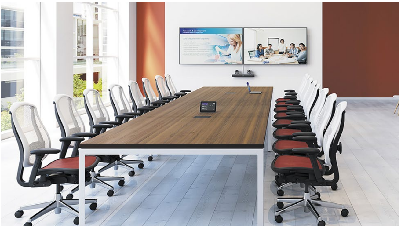
L'équipement classique d'une salle en visioconférence comprend deux grands écrans, une ou deux caméras et une unité de traitement et de communication, le codec. © Poly
