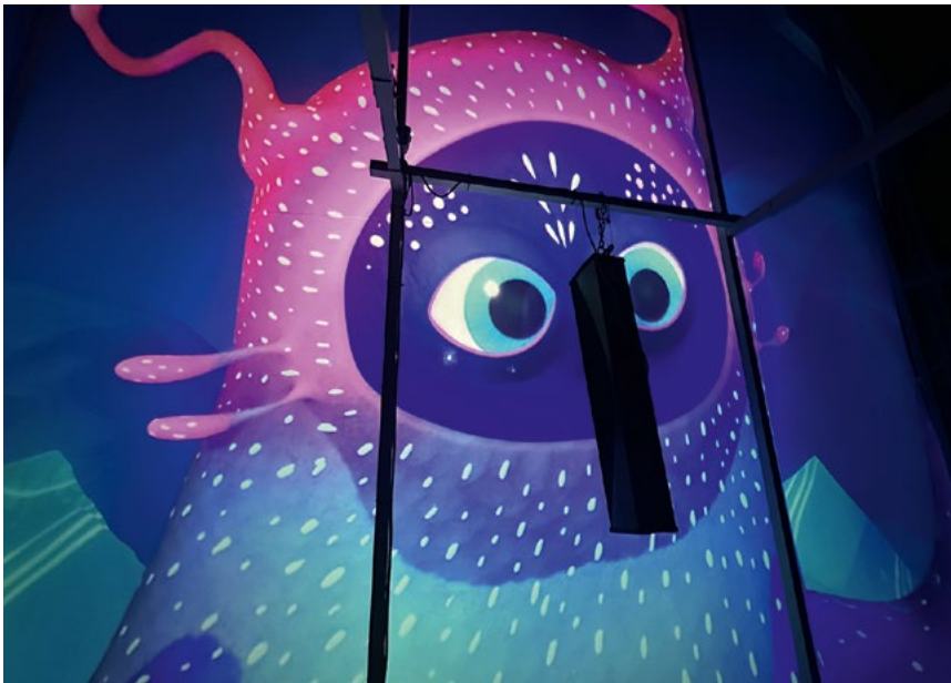
Des enceintes Nexo ID84 habilement dissimulées derrière l'écran en toile suspendue micro perforée du Kiné'eau. © Nathalie Klimberg
